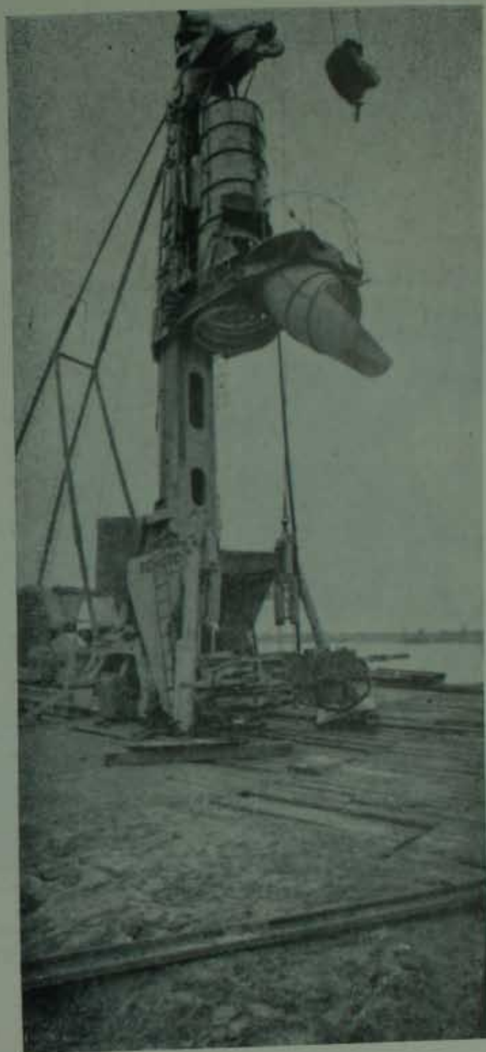
Fotografia prototipului mașinii de forat importată de la firma „Benoto“, care nu a realizat și nu realizează nici în prezent parametrii tehnici stipulați în contract.
