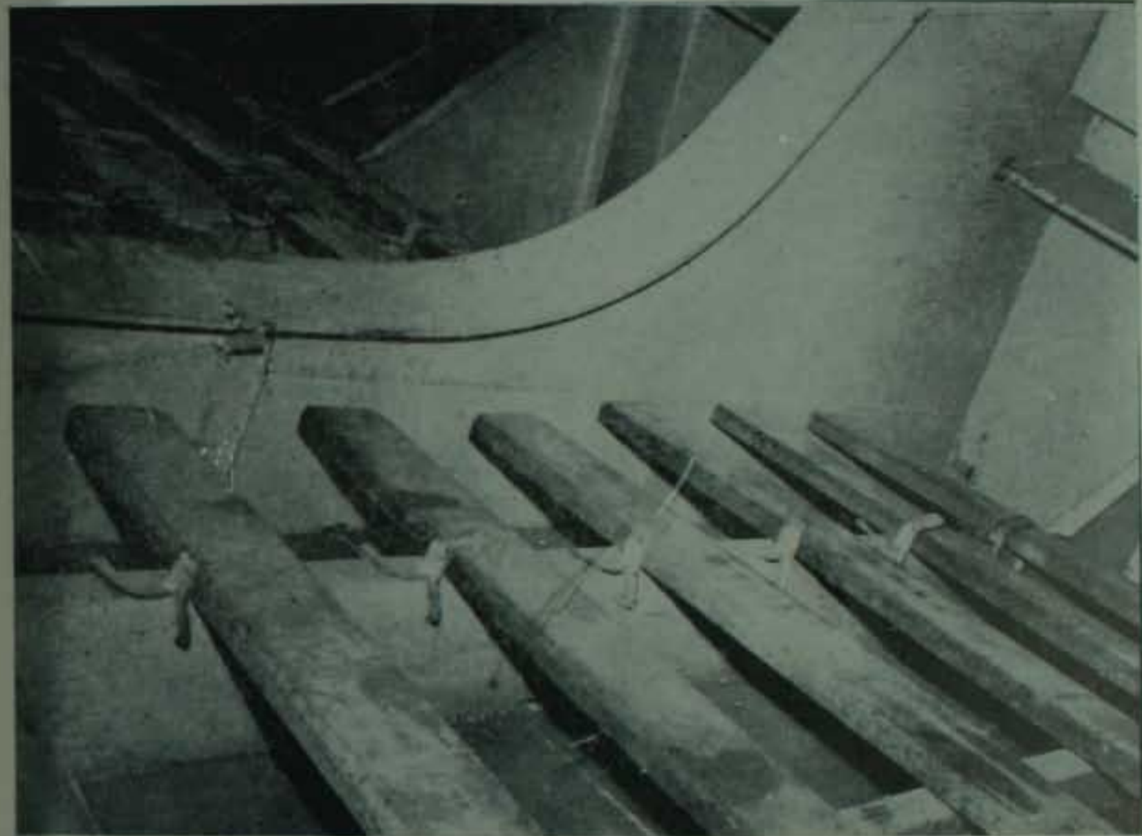
Imbinarea scheletului și sudurile făcute în mod necorespunzător la unul dintre cargouri.
